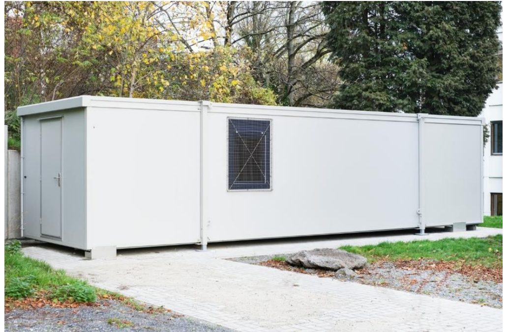
ENVI-EHS: Duplication des installations de tests à ISSeP-Liège
